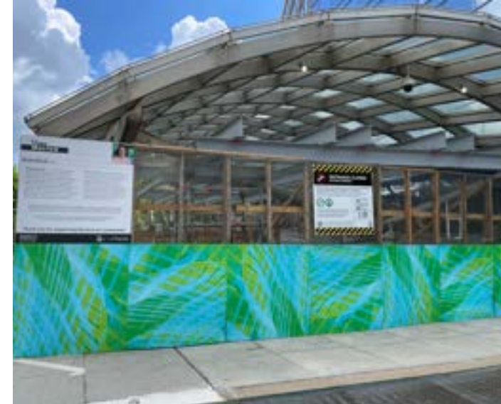
L'Enfant Plaza | Construction Barricades
